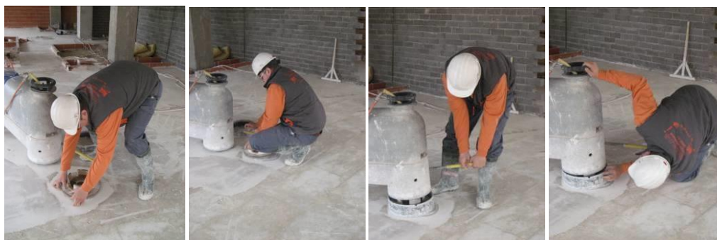
Posturas del trabajador durante el cambio de piedra pulidora
