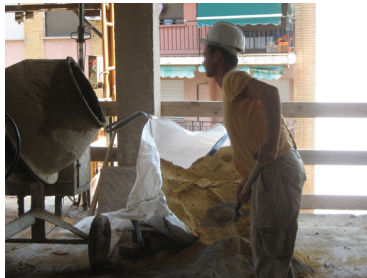
Cargar la homigonera con la pala provoca:
