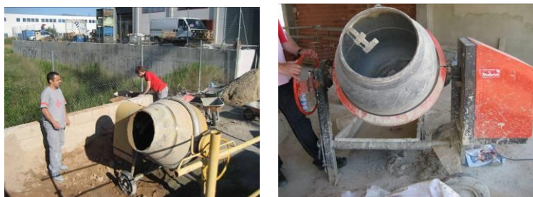
Ubicación de hormigoneras exterior/interior
