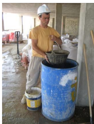
Limpieza de la hormigonera. Posturas forzadas
