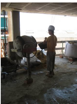
Limpieza de la hormigonera. Posturas forzadas
