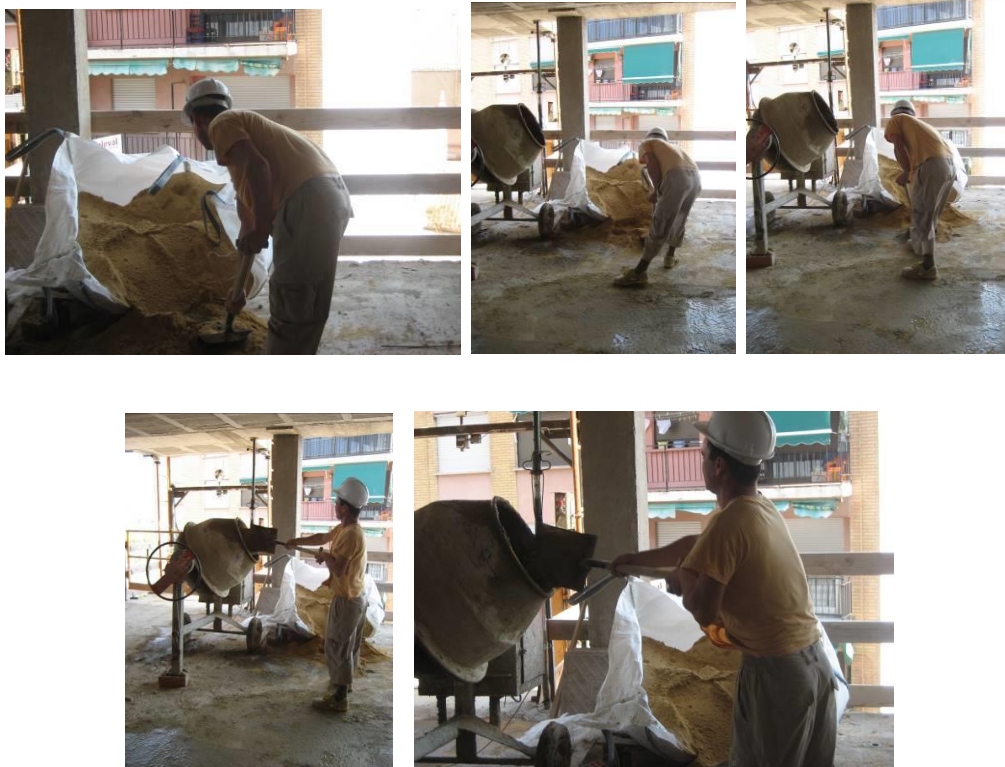
Carga de la hormigonera. Posturas forzadas
