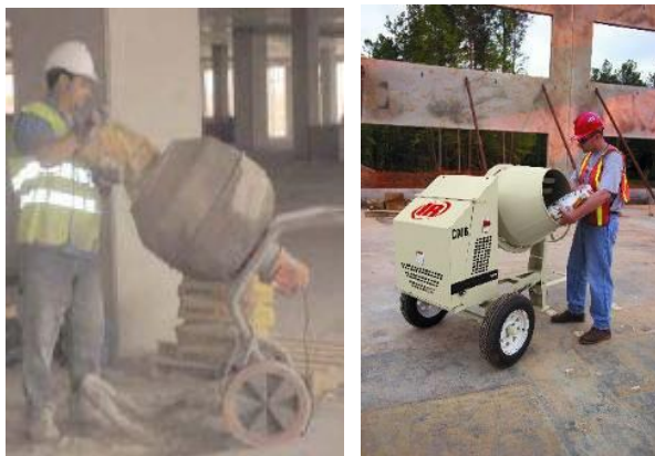
Carga de la hormigonera. Posturas forzadas
