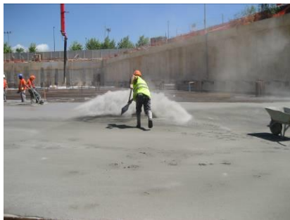
Polvo generado en la distribución del endurecedor
