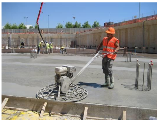
Fratasado en zonas de difícil acceso
