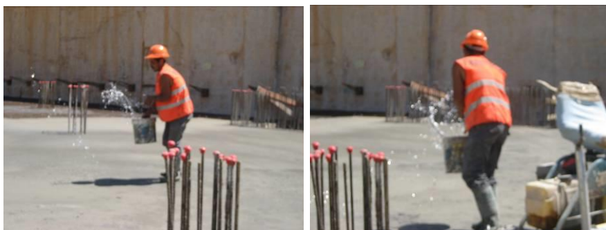
Posturas en la distribución de agua por la superficie a fratar
