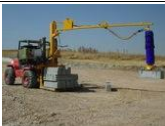
Imagen 15. Maquinaria de colocación de bordillos y adoquines
