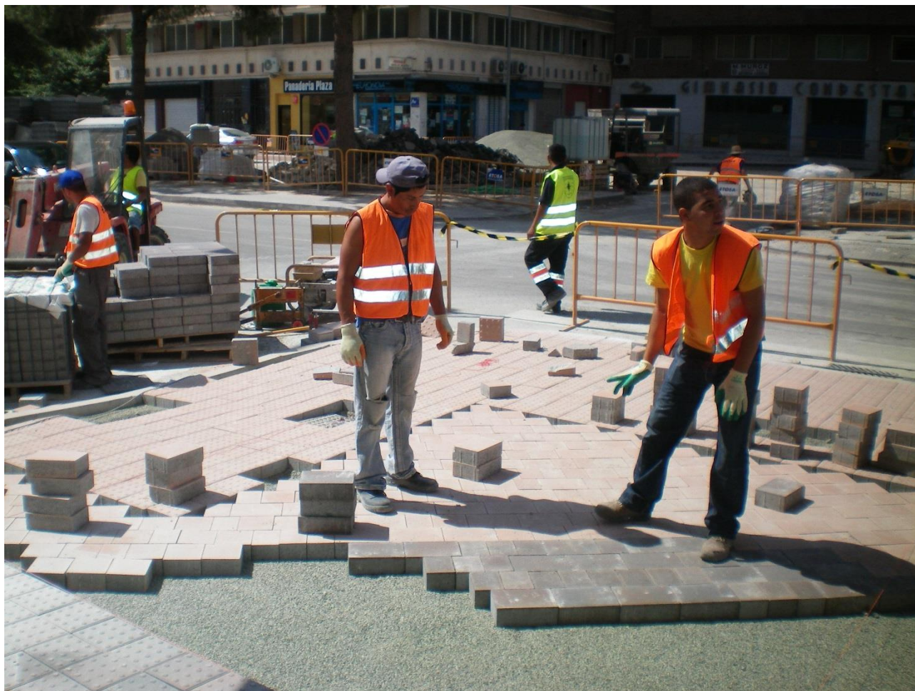
Imagen 9. Señalización y vallado durante acerado.
