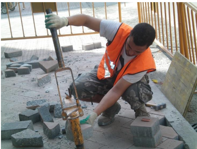
Imagen 37. Vallado de la zona afectada. Trabajo en cuclillas.
