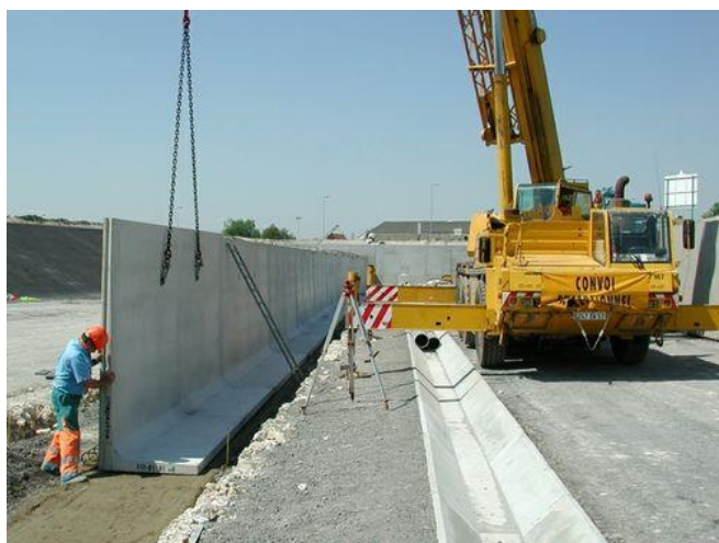
Imagen 13. Colocación de muro de homigón armado prefabricado modular
