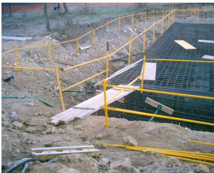
Imagen 18. Pasarela de acceso a la zapata
