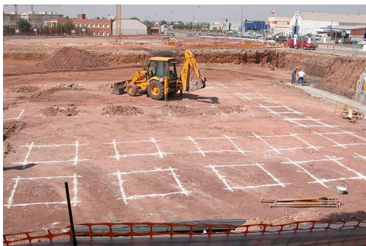
Imagen 4. Replanteo de la zapata.
