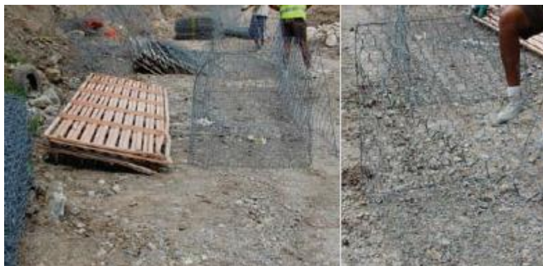
Imagen 3. Armado de la malla del gavión
