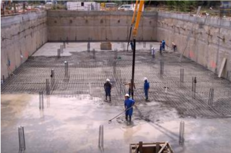
Imagen 16. Zapatas. Fase de hormigonado.
