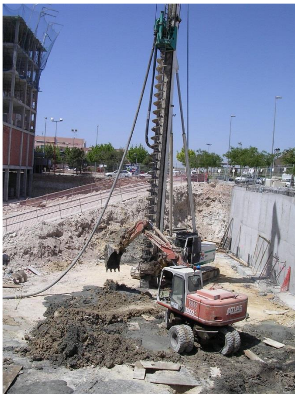
Imagen 21. Perforación. Presencia de maquinaria en espacios limitados
