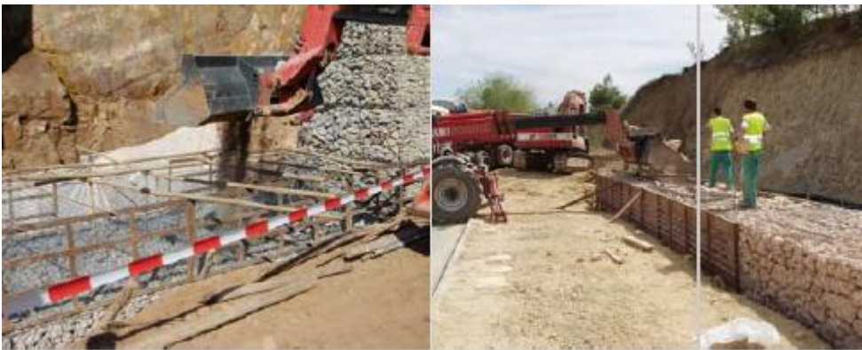
Imagen 5. Relleno de gavión
