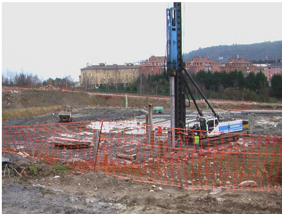
Imagen 20. Proceso de hinca. Delimitación de la zona. Presencia de personal y maquinaria móvil.
