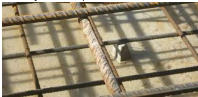
Imagen 22. Recubrimiento de las armaduras. Separadores.
