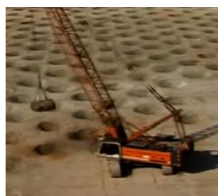
Imagen 6. Compactador dinámico.
