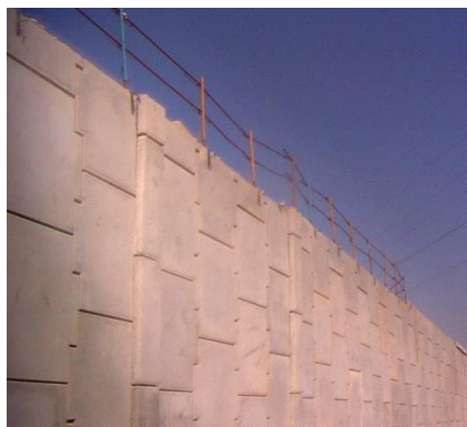
Imagen 30. Muro tierra armada. Protección perimetral
