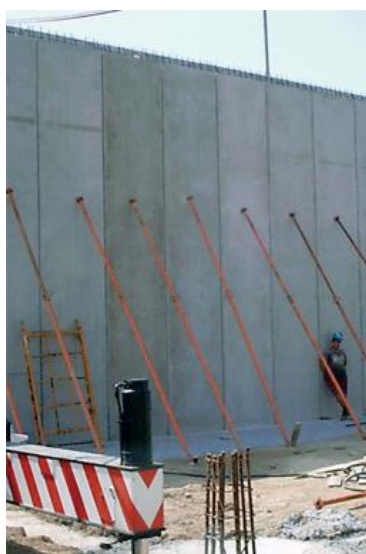
Imagen 12. Muro de contención prefabricado
