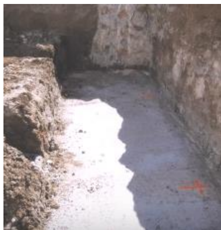
Imagen 8. Hormigón de limpieza.
