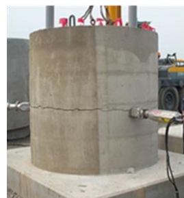
Imagen 28. Quebrantador hidráulico
