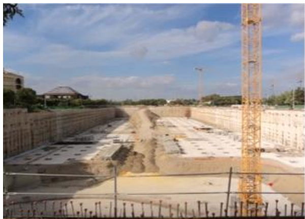
Imagen 15. Aspecto general. Protecciones colectivas en la zona
