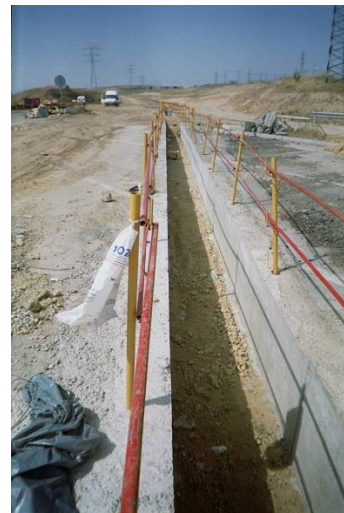
Imagen 35. Protección perimetral de murete guía para pantalla de hormigón
