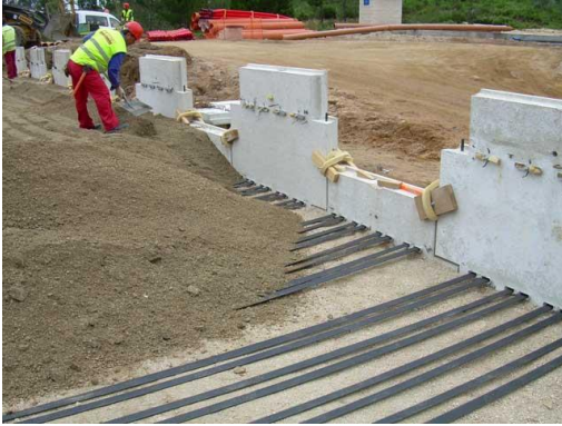
Imagen 27. Ejecución de muro de tierra armada
