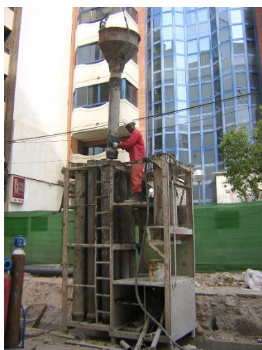
Imagen 40. Formación de la tubería tremie
