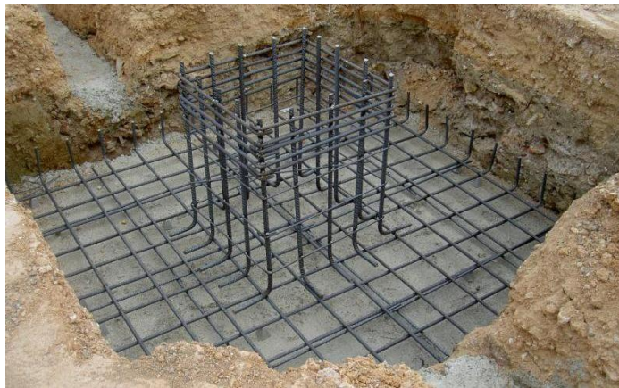
Imagen 9. Colocación de armadura
