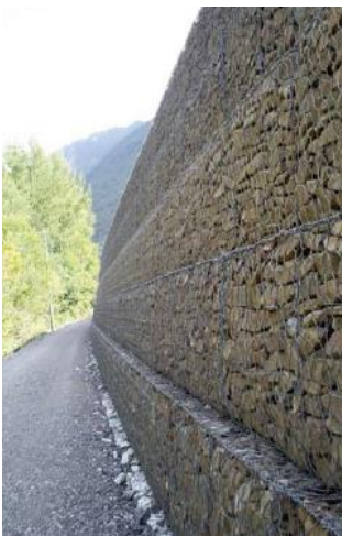
Imagen 2. Gavión en carretera
