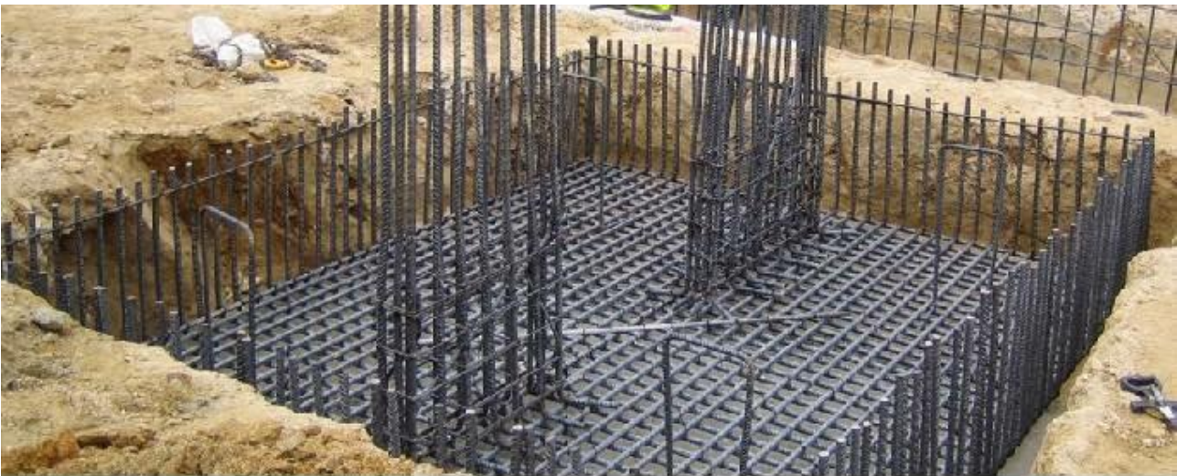
Imagen 3. Zapata combinada
