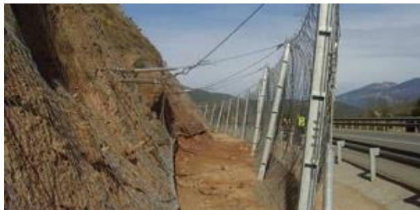
Imagen 11. Pantalla dinámica
