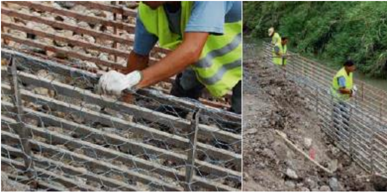
Imagen 4. Atado de gaviones
