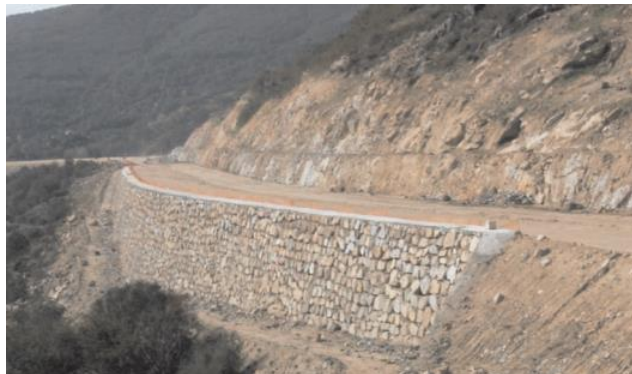
Imagen 10. Muro de sostenimiento de escollera colocada. Fuente: Guía para el proyecto y la ejecución de muros de escollera en obras de carretera. Dirección General de Carreteras.
