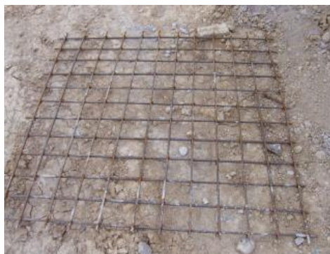
Imagen 7. Mallazo para el hormigón de limpieza.
