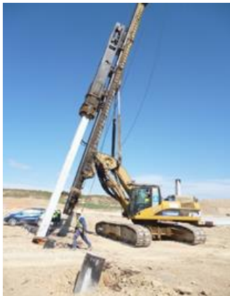
Imagen 56. Hincadora de pilotes
