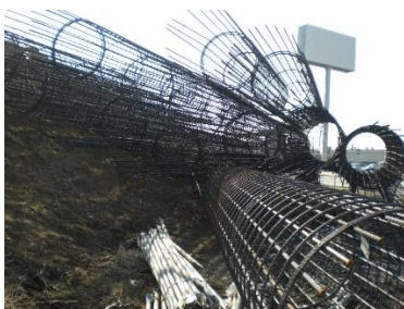
Imagen 47. Acopio indebido
