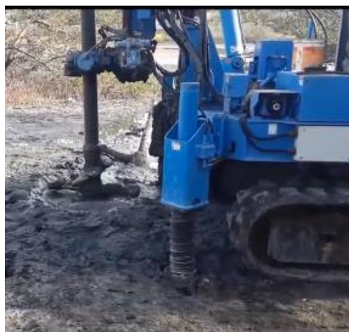
Imagen 12. Deep soil mixing. Equipo en ejecución.
