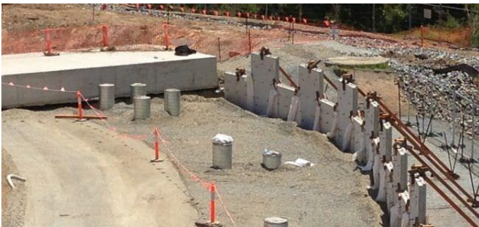
Imagen 28. Ejecución de Muro de tierra armada.
