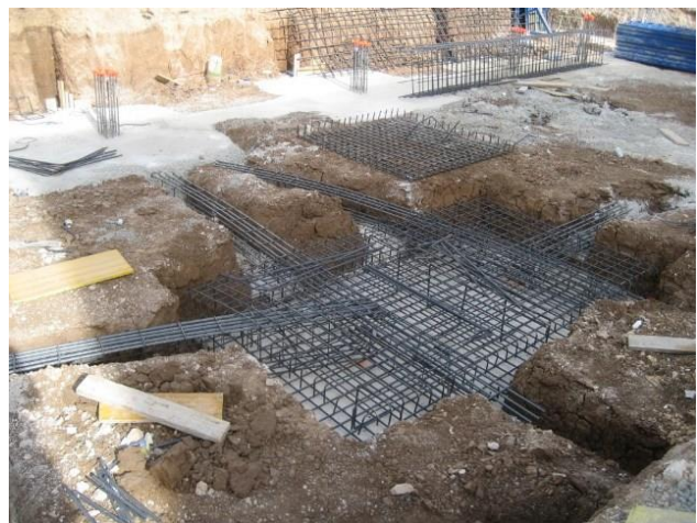
Imagen 11. Armado de zapatas. Distintas fases de ejecución.
