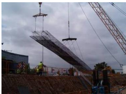
Imagen 38. Izado de armadura
