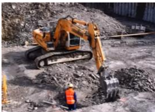
Imagen 5. Excavado con retroexcavadora. Acto inseguro: nadie debe permanecer en el entorno de la retroexcavadora
