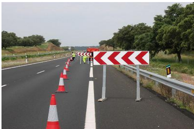
Imagen 20. Colocación de conos en diagonal para corte de carril.
