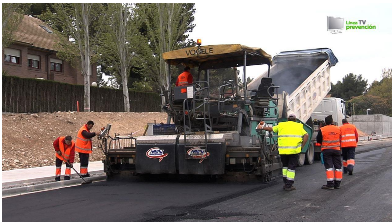
Imagen 11. Extendedora de productos bituminosos.
