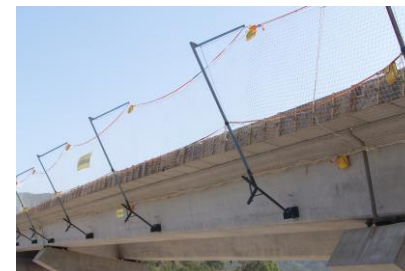
Imagen 32. La colocación de las redes puede realizarse en el suelo. Previamente a ser colocadas las vigas en su ubicación definitiva
