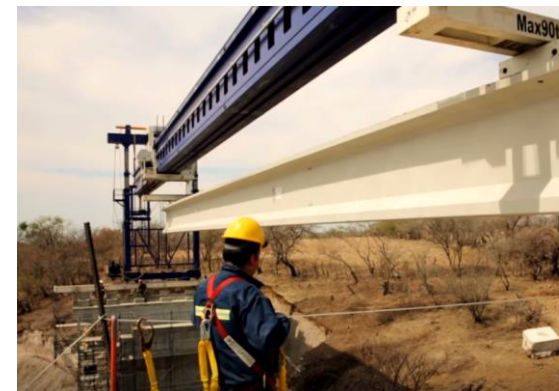
Imagen 47. Acoplamiento de la viga sobre la pila. Fuente: https://www.youtube.com/watch?v=gAjSOkUZFLk&feature=youtu.be
