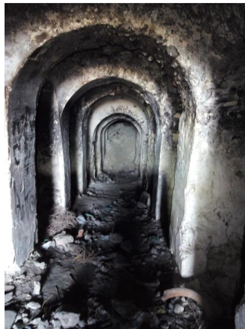
Imagen 7. Ejemplo de túnel excavado a pico y pala. Ejecutado en 1703 (Chinchón. Comunidad de Madrid)
