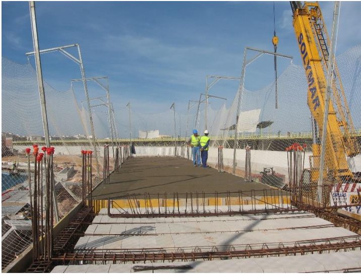
Imagen 22: Ejemplo de entrevigado de hormigón
