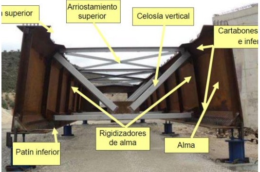
Imagen 38: Montaje de la estructura metálica en taller. Partes que la componen. Fuente: basado en la presentación de Francisco Millanes en el Seminario Internacional de Puentes 2018
