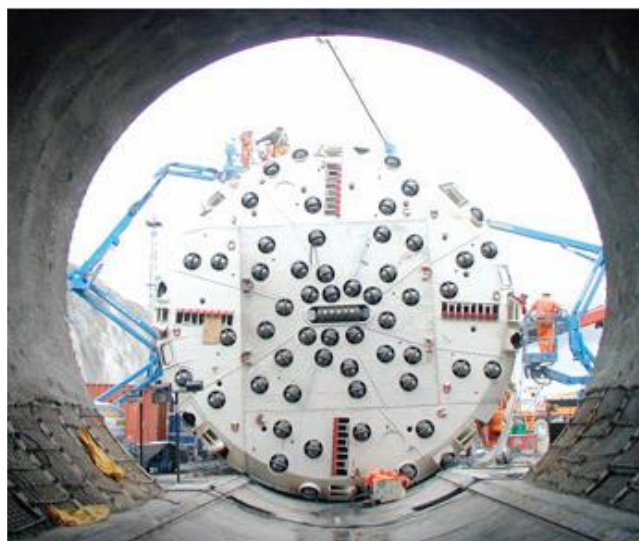
Imagen 29. Cabeza de corte de tuneladora de doble escudo en el túnel de Guadarrama. Fuente: Revista Cimbra. Del colegio de ingenieros técnicos de Obras Públicas e Ingenieros Civiles.
