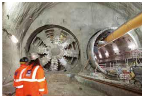
Imagen 28. Tuneladora de escudos simple en el túnel de Stepney Green. Fuente: Revista de Obras Públicas. Monográfico túneles. Septiembre 2016.
