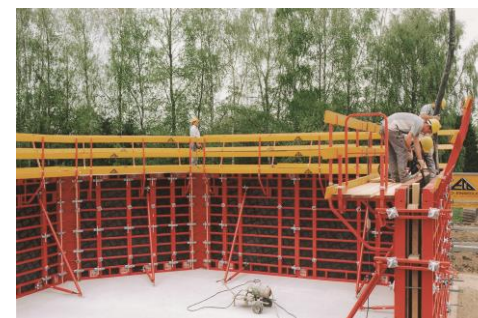
Imagen 11: Equipo de hormigonado y vibrado. El gruísta observa en posición que permite controlar los movimientos de la manguera de bombeo.
