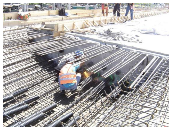
Imagen 21: Corte de los tendones después del tensionado. Fuente: European Commission. Seminario 2012 "Diseñando puentes con Eurocódigos".
