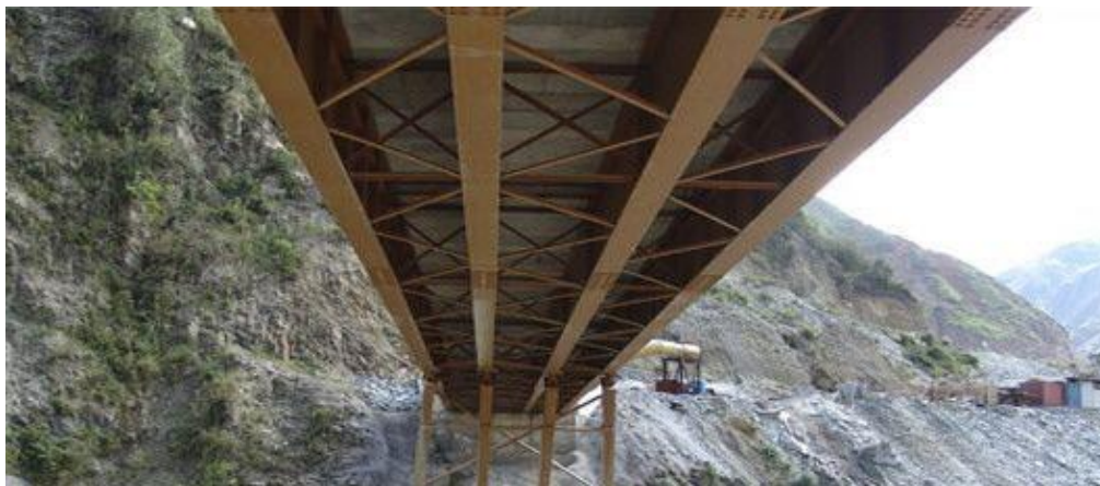
Imagen 32: Puente mixto con vigas metálicas.
