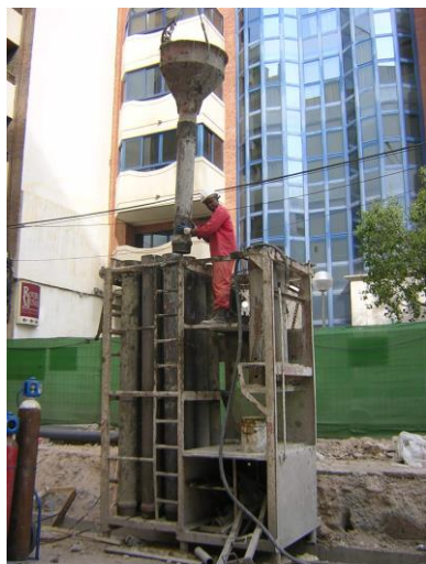
Imagen 12. Hormigonado con castilletes de hormigonado.
