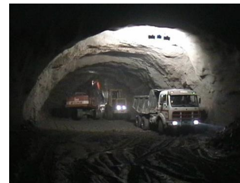
Imagen 12. Carga de camión en el interior del túnel. Como es habitual, hay poco espacio de maniobra entre las distintas máquinas. Se comprobará la no interferencia en el radio de acción de cada una.
