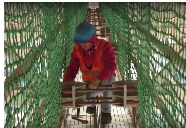
Imagen 17. sistema de anclaje y cierre de las dos mitades. Fuente: www.berd.eu
