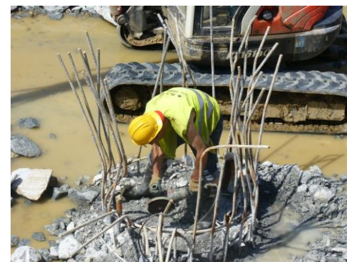
Imagen 28: Descabezado de pilotes
