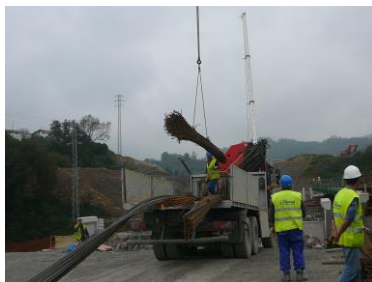
Imagen 24: Posición adecuada de los trabajadores respecto al izado de cargas
