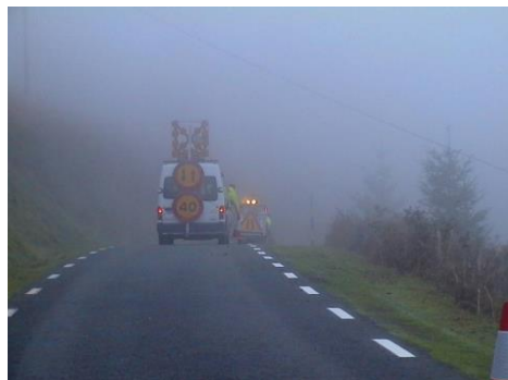
Imagen 4: Señalización de obras. Vehículo de apoyo. Señales luminosas muy necesarias para advertir con antelación a los conductores.
