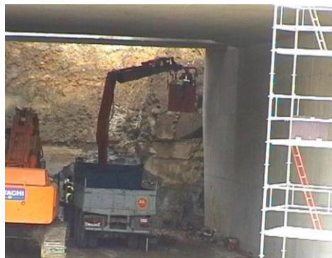
Imagen 7. Acceso a la zona de excavación mediante andamios o elevadores que permitan al trabajador la ejecución de los trabajos en la altura adecuada.
