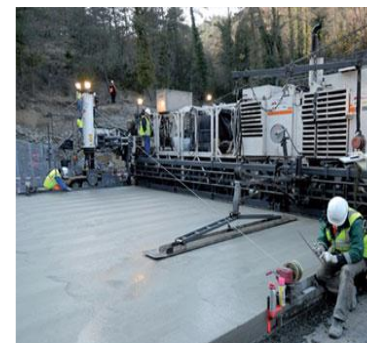
Imagen 8. Proceso de pavimentación y reparto del hormigón Fuente: Manual de formación en ingeniería de carreteras de aulacarreteras.com
