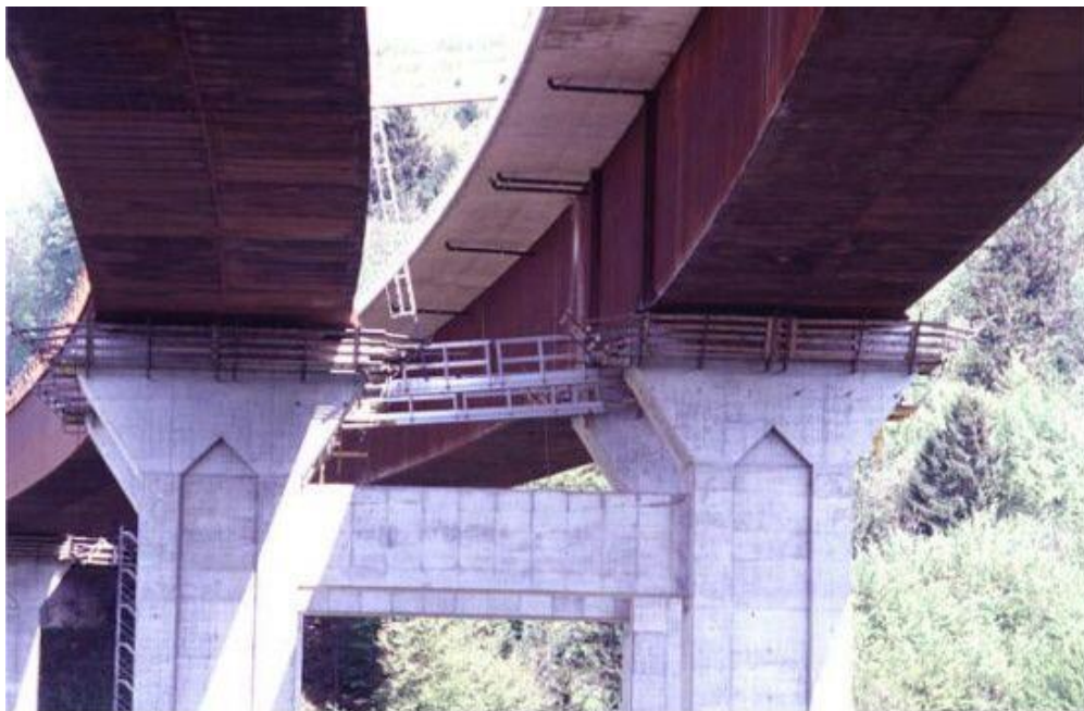
Imagen 31: Puente mixto tipo cajón.
