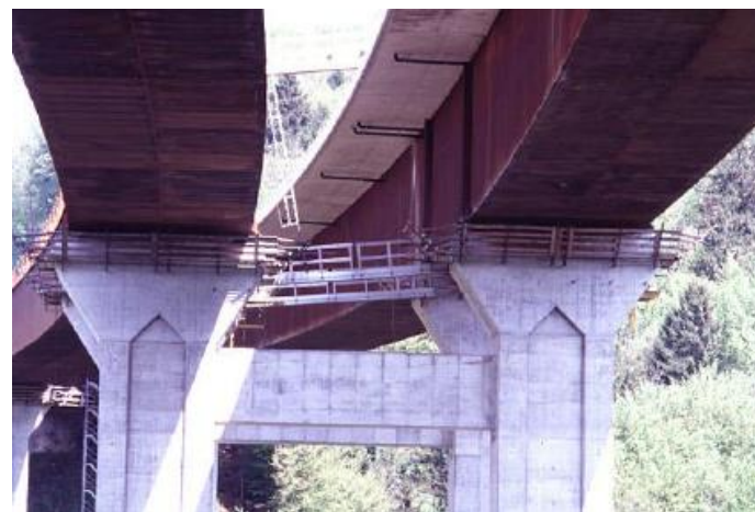
Imagen 40: Hormigonado del tablero. El acceso al tablero se realiza mediante escaleras de andamio. Protecciones colectivas previas. Fuente: Universidad de Caminos, Canales y Puertos. Curso de puentes II.
