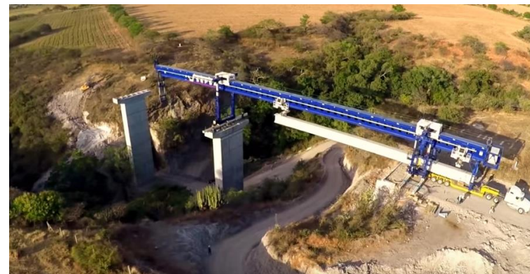
Imagen 43: instalación de la viga en el sistema de lanzamiento. Fuente:
