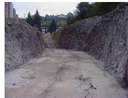
Imagen 6. Base del pavimento.
