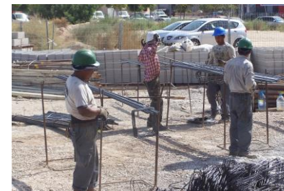
Imagen 23: Taller de ferralla en obra. Zona de trabajo adecuada con espacio y organización. Uso de equipos de protección
