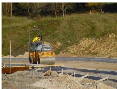
Imagen 5. Compactación de la base del pavimento.
