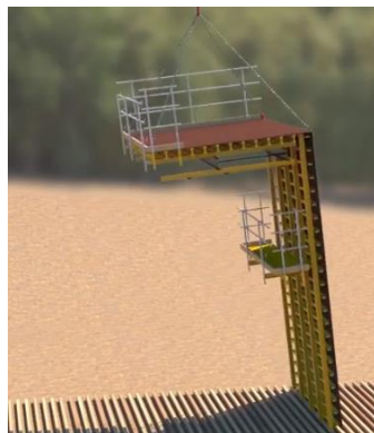
Imagen 23. Encofrado con todas las protecciones montadas sobre el suelo, antes del izado. Fuente: Basado en esquemas de ULMA.
