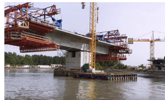
Imagen 22. Zona anexa prevista para colocación de grúa, materiales, etc. Fuente: Senegabia Gridge. https://www.youtube.com/watch?v=x3XhDwtl4ZI&feature
