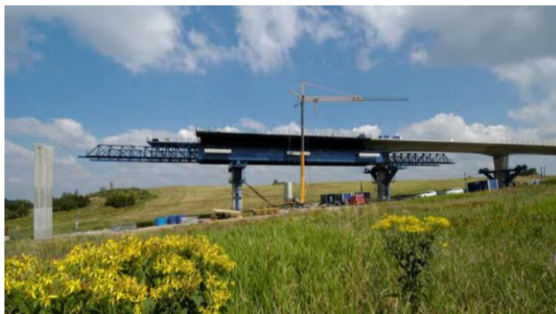
Imagen 11. Autocimbra bajo tablero, en el momento de extender las vigas hacia la siguiente pila. Fuente: http://www.berd.eu/
