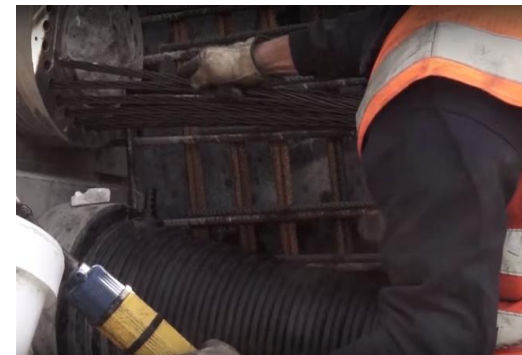
Imagen 15. Aplicación del postesado antes de proceder a mover el sistema. Fuente: http://www.berd.eu/
