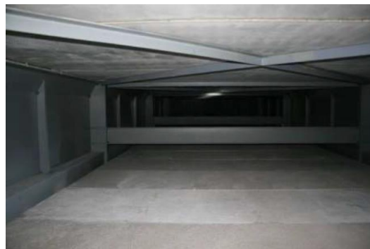
Imagen 35: Interior puente con bijáccena doble acción mixta, totalmente transitable. Fuente: Viaducto Mularroya en presentación de Francisco Millanes en el Seminario Internacional de Puentes 2018.
