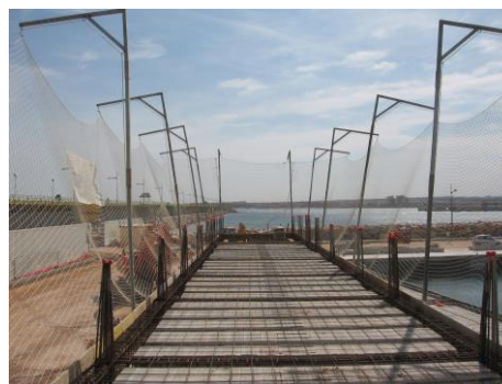
Imagen 9. Preparación de hormigonado con protecciones colectivas. Sargentos y redes.
