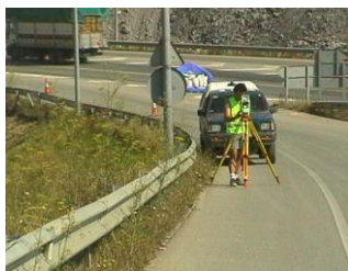
Imagen 2: replanteo de trazado de carretera. Riesgo de atropellos
