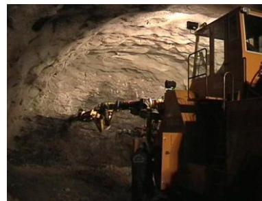
Imagen 11. Excavación mediante accesorios de perforación.
