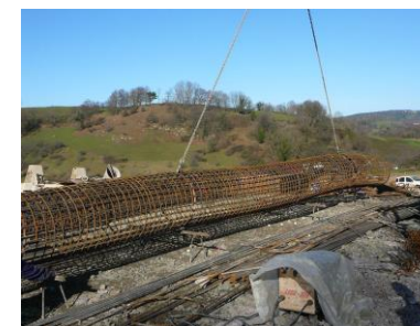
Imagen 25. Transporte horizontal de pilares hasta su colocación exacta.
