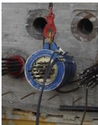
Imagen 20: Tensionado de los tendones al comienzo de la losa. Fuente: European Commission. Seminario 2012 "Diseñando puentes con Eurocódigos".
