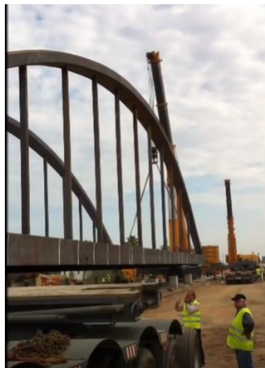
Imagen 29. Elevación simultánea de la estructura entre varias grúas. Director de montaje dando instrucciones.
