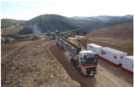
Imágenes 36-37: Transporte por carretera de vigas y cajón metálicos. Fuente: Construcción río Turia (Valencia) y presentación de Francisco Millanes en el Seminario Internacional de Puentes 2018
