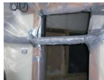
Imagen 20 Protección de elementos
