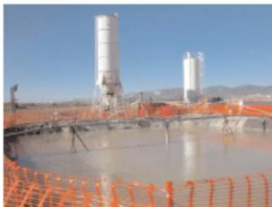
Imagen 35. Planta de lodos bentoníticos. Fuente: "Prevención riesgos laborales en el sector Construcción. Generalitat de Catalunya.
