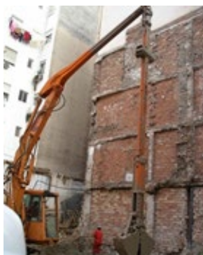
Equipo de trabajo: Pantalladora Aceleración m/s^2 : 0.4-0.9 m/s^2
