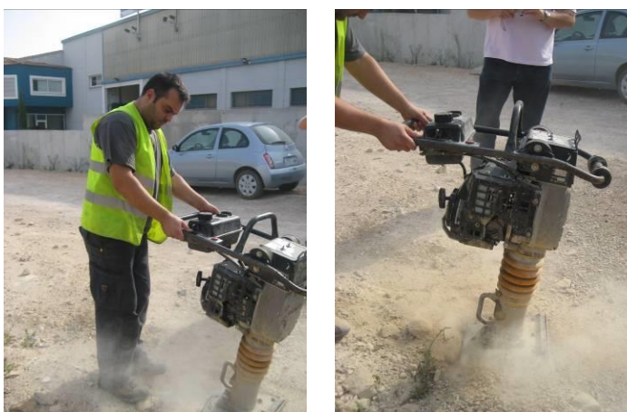
Polvo producido durante la compactación.
