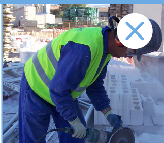
Sin sistema de supresión de polvo ni EPR
